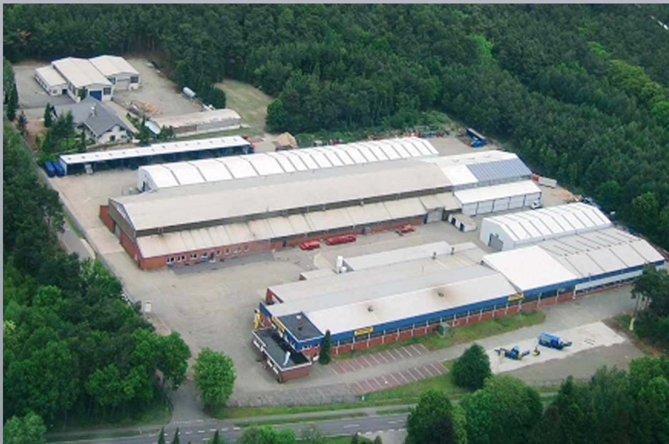
A Husmann központja Lathenben
