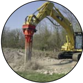
ALLU PM Power Mix - összekeveri a talajt és a kötőanyagot a stabilizálás során
