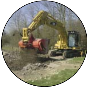
ALLU őráló-rostáló kanálkeveri / rostálja a talajt és a kötőanyagot
